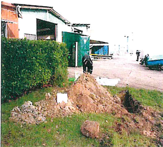
Illustrazione 23: cumulo del materiale scavato
