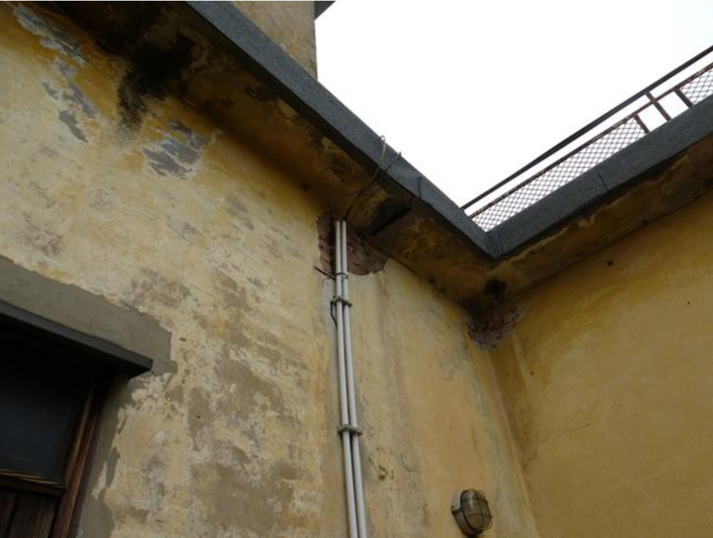
DEGRADO DELLA CORNICE IN C.A.
