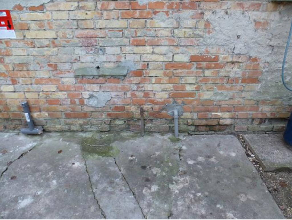
DEGRADO DELL'INTONACO
