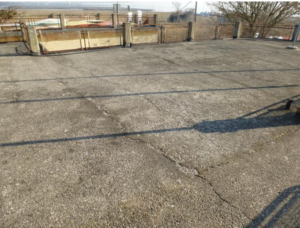
DEGRADO DELLA PAVIMENTAZIONE TERRAZZA
