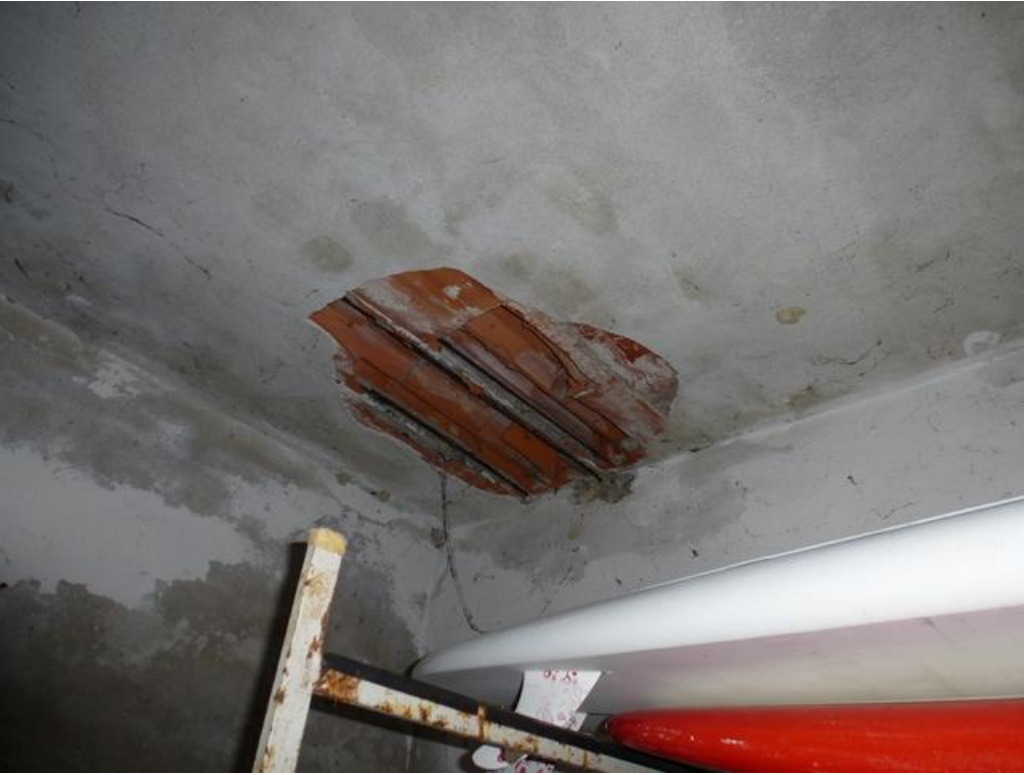
DEGRADO DEL SOLAIO IN LATEROCEMENTO
