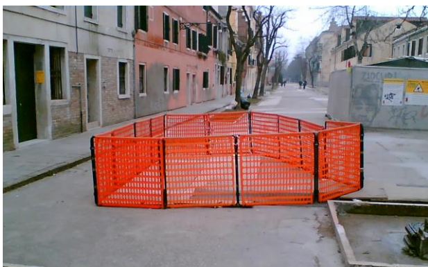
Figura 19 Assito in transenne modulari
