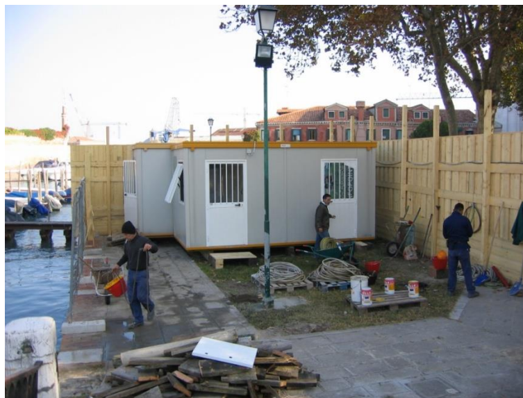
Figura 23 Installazione Box di cantiere a quota protetta
