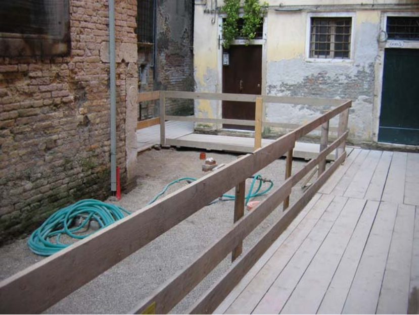
Protezione scavo per formazione passaggio temporaneo
