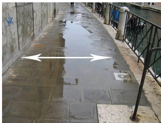
Esempi di ostruzione al 100%; entrambi gli avvallamenti hanno larghezza maggiore di 1,2 m.
