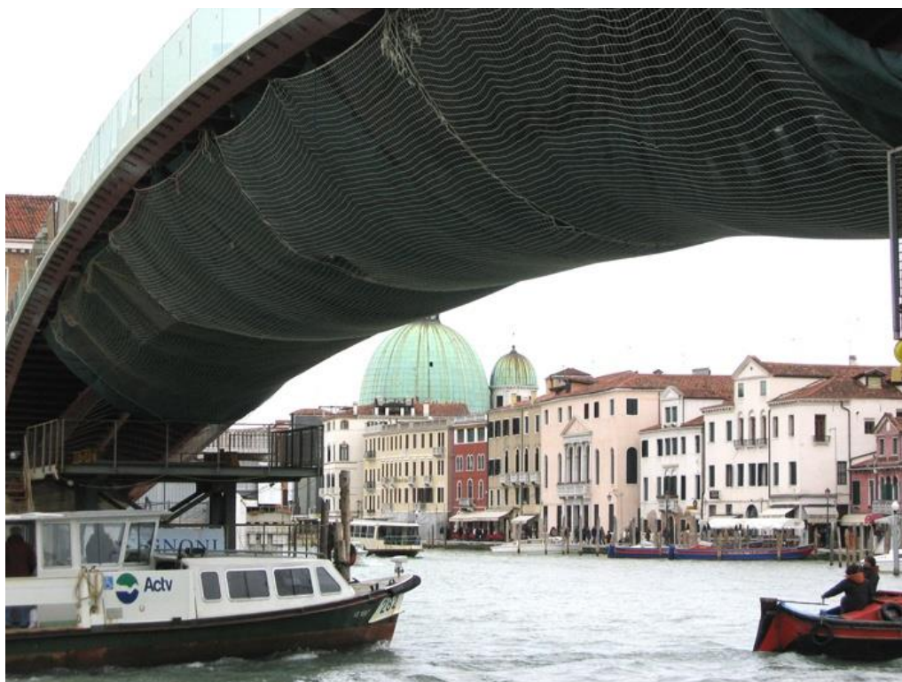
Figura 31 Protezione cantiere ponte per la viabilità pubblica
