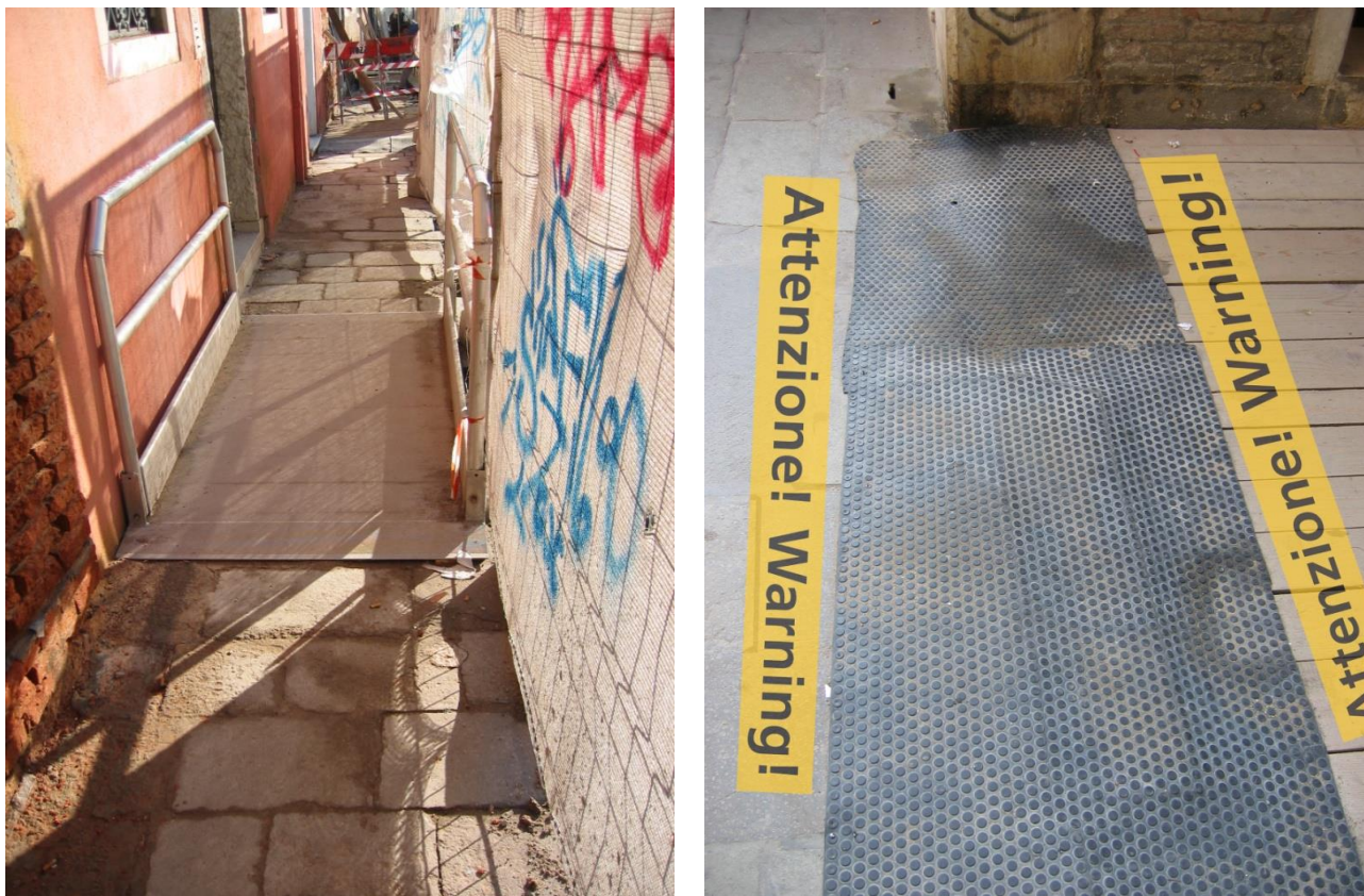
Figura 29 Esempi di passerelle pedonali e soluzione tecnica per evitare l'eventuale dislivello dovuto allo spessore delle tavole
