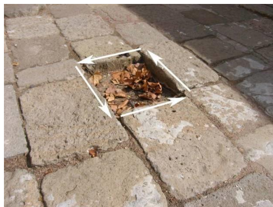
Esempio di mancanza totale di uno o più elementi
