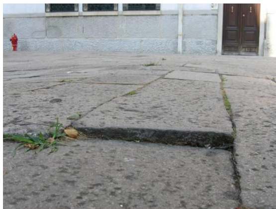
Cedimento di un singolo elemento rispetto piano della calle
