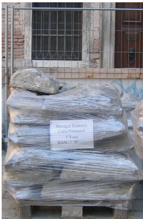
Figura 28 Esempi stoccaggio masegni
