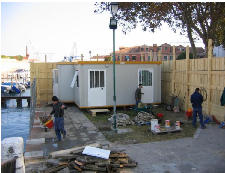
Figura 18 Installazione Box di cantiere a quota protetta
