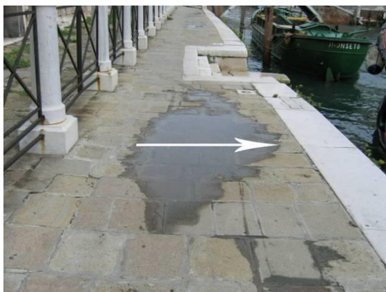
Esempio ulteriore di avvallamento di dimensioni contenute ma costituente un grave ostacolo ai pedoni.
