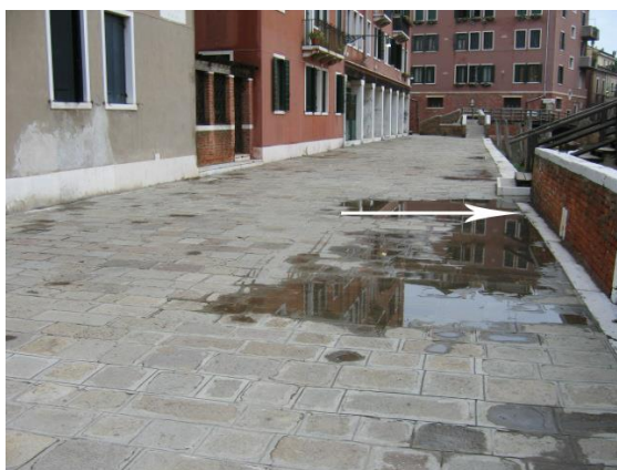
Avvallamento dalla larghezza > 1,2 m ma grado di ostruzione relativamente basso (25 -50 %).
