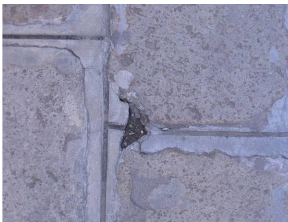
Pavimentazione a giunto fugato
