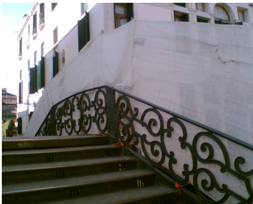
Figura 12 Assito in tavole e rete antipolvere
