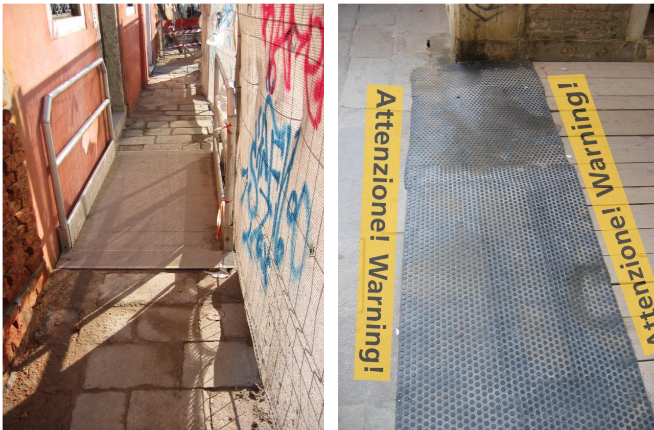
Figura 24 Esempi di passerelle pedonali e soluzione tecnica per evitare l'eventuale dislivello dovuto allo spessore delle tavole
