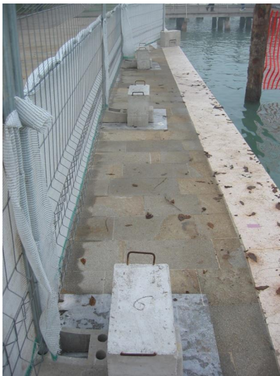
Figura 10 - Esempio di zavorra antiribaltamento
