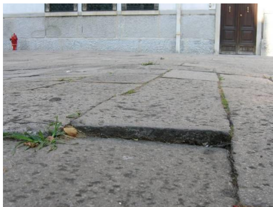
Cedimento di un singolo elemento rispetto piano della calle
