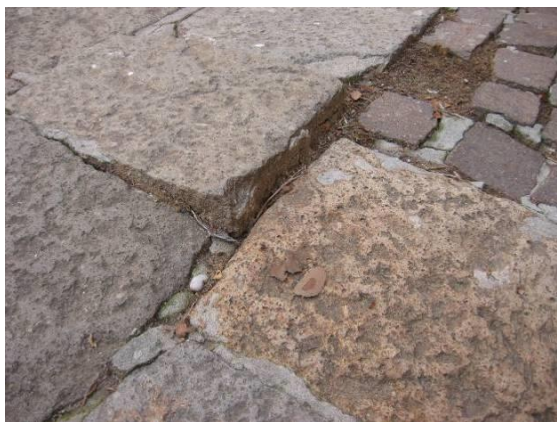
Rialzo di un singolo elemento rispetto piano della calle
