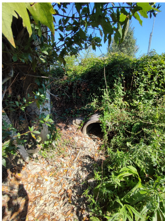
Figura 15. Fossato nord: condotta DN 800 mm verso fossato est esistente
