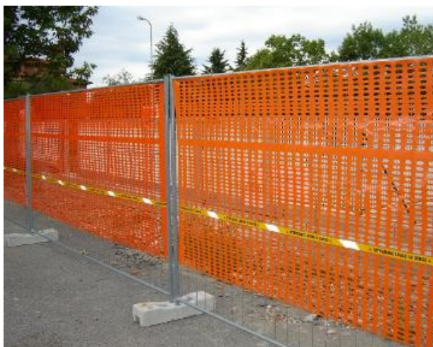
Rete zincata e basi in cls con rete plastificata arancione
