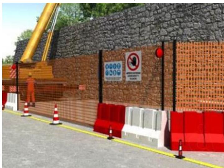
Rete zincata e basi in cls con rete plastificata arancione e protezioni/segnalazioni cantiere stradale
