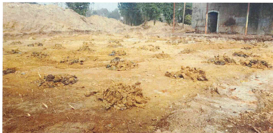
ESECUZIONE DELLE TRIVELLAZIONI PER BONIFICA PROFONDA SUCCESSIVA ALLO SCAVO DI SBANCAMENTO
