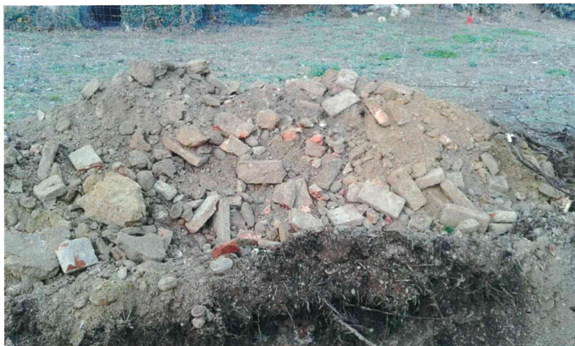
SCAVI DI VERIFICA EFFETTUATI - SI EVIDENZIA LA PRESENZA DI MATERIALE DI RIPORTO
