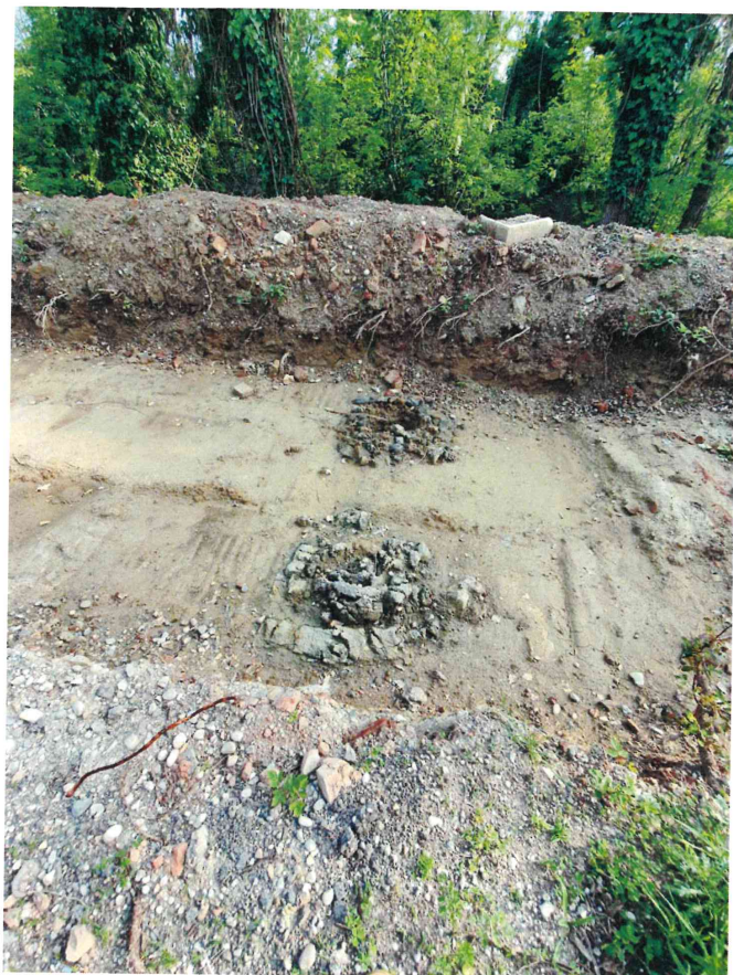
TRIVELLAZIONI EFFETTUATE PER STABILIRE LA PROFONDITA' DEL MATERIALE DI RIPORETO
