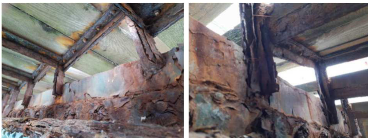
Figura 10 Dettagli dello stato di ossidazione delle parti metalliche delle strutture secondarie a supporto dei gradini
