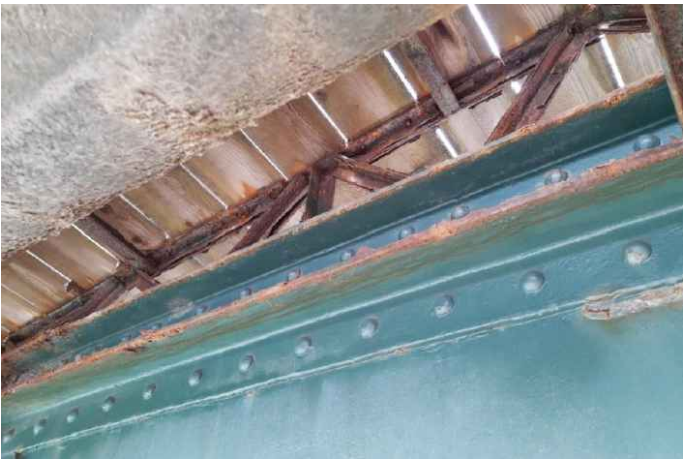
Forte corrosione nelle strutture principali da restaurare
