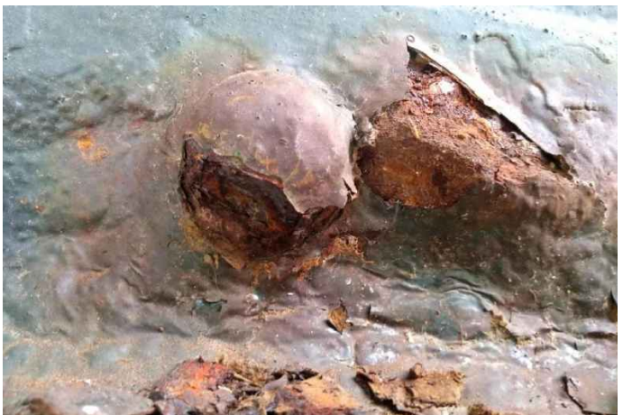
Corrosione e ammoramento delle chiodature / bullonature nelle piastre di collegamento nelle giunzioni
