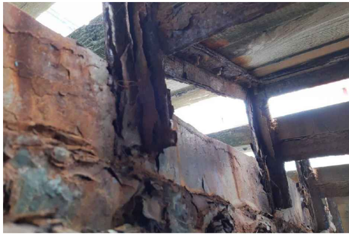
Forte corrosione della struttura dei gradini da eliminare
