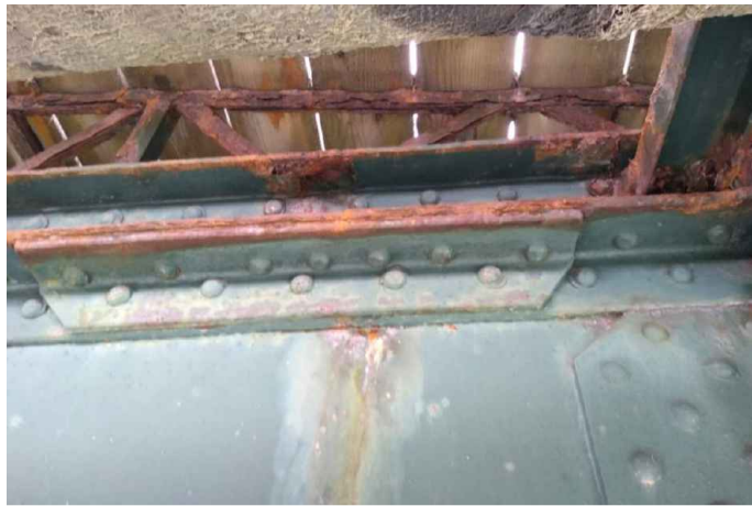
Forte corrosione della struttura dei gradini da eliminare
