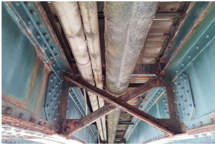
Forte corrosione rinforzi trasversali e controventi (da eliminare)
