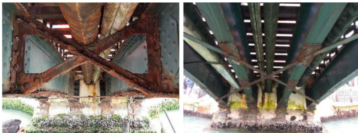
Figura 12 Croce di irrigidimento trasversale e croce di controventamento all'intradosso del ponte
