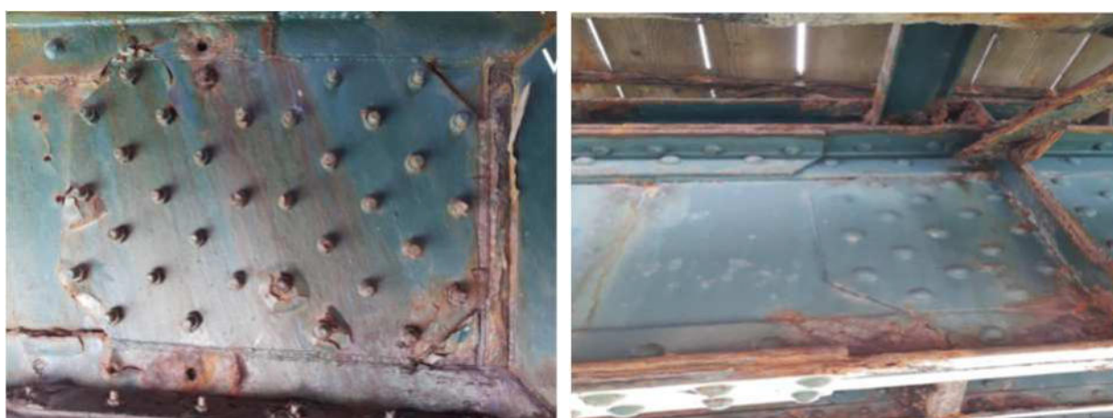
Figura 13 Dettagli dei giunti delle travi principali
