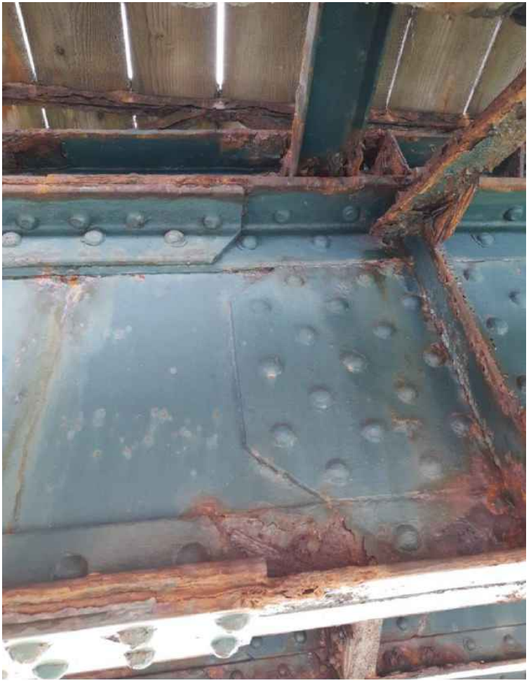
Corrosione e ammoramento delle chiodature / bullonature nelle piastre di collegamento nelle giunzioni
