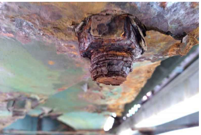
Corrosione e ammoramento delle chiodature / bullonature nelle piastre di collegamento nelle giunzioni
