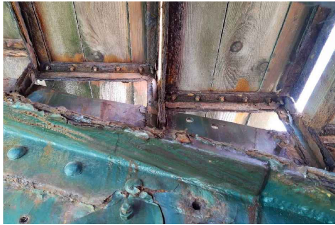
Forte corrosione dei lampioni e dei parapetti del ponte
