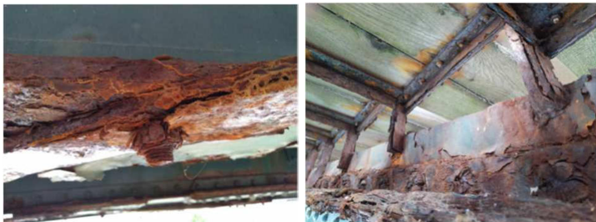
Figura 17 Dettagli esfoliazione profili e corrosione bulloni di recente fattura
