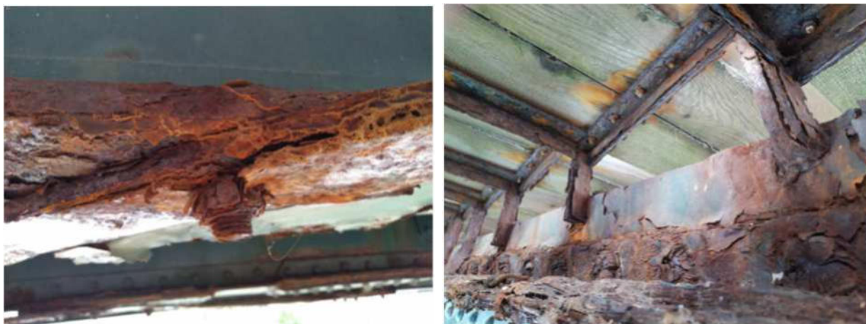
Figura 14 Dettagli esfoliazione profili e corrosione bulloni di recente fattura
