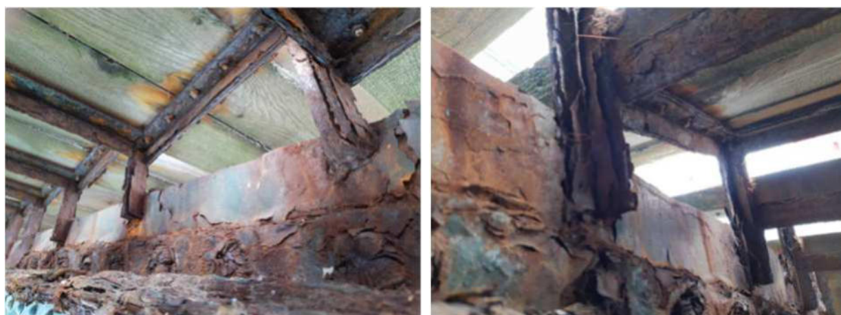
Figura 13 Dettagli dello stato di ossidazione delle parti metalliche delle strutture secondarie a supporto dei gradini
