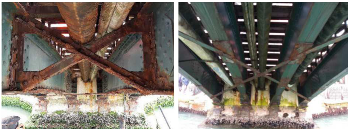
Figura 9 Croce di irrigidimento trasversale e croce di controventamento all’intradosso del ponte
