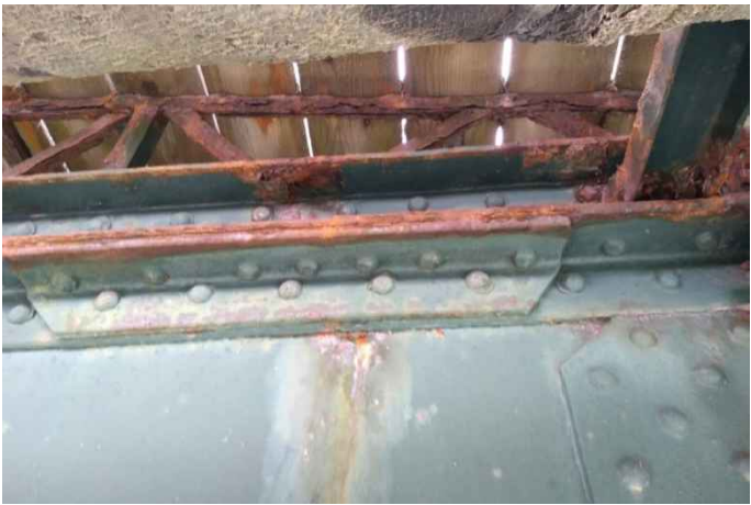
Forte corrosione nelle strutture principali da restaurare
