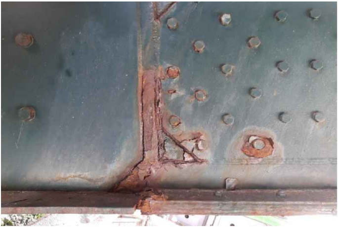
Corrosione e ammoramento delle chiodature / bullonature nelle piastre di collegamento nelle giunzioni
