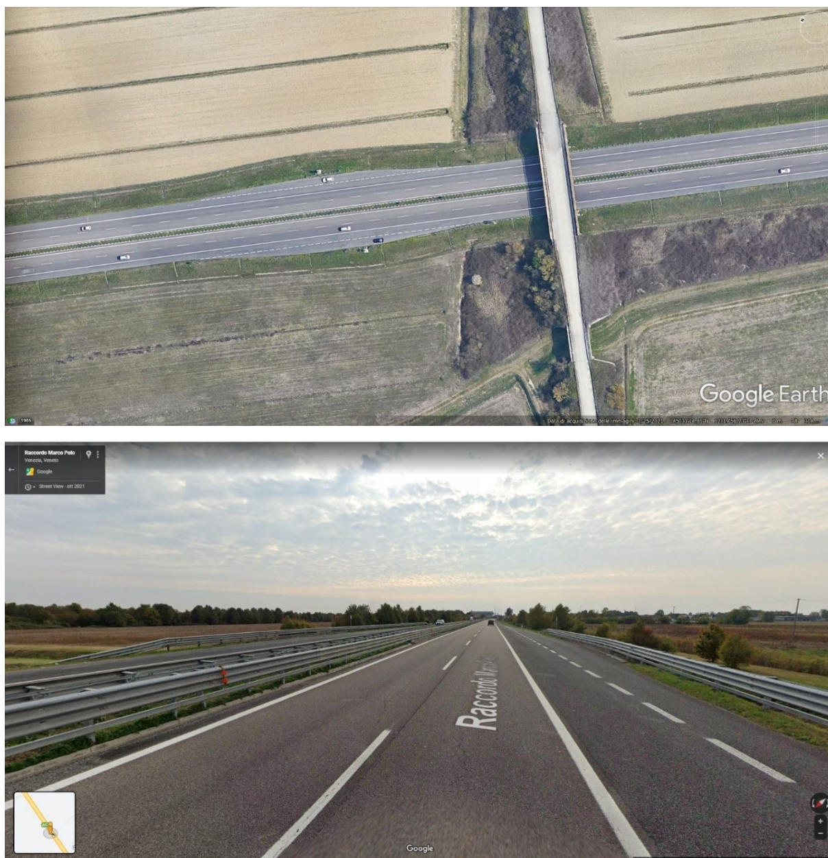
FIGURA 2: VISTA DELLA BRETELLA DI RACCORDO ALL'AEROPORTO MARCO POLO (MP) NEL TRATTO IN AFFIANCAMENTO ALL'AREA DI INTERVENTO
