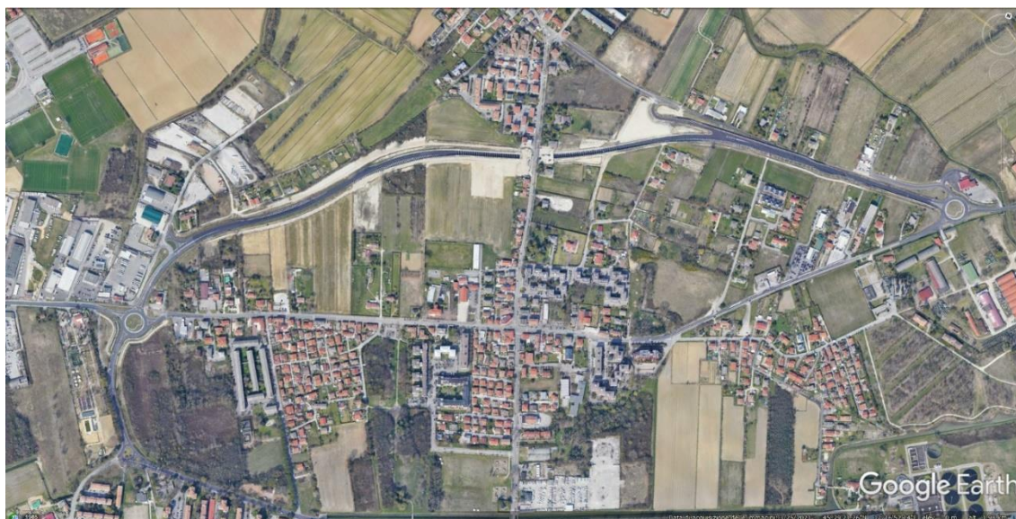
FIGURA 7: VISTA DELLA S.S. 14 NEL TRATTO PRESSO L'ABITATO DI CAMPALTO E DELLA VARIANTE DI CAMPALTO CHE CONDENE DI BY-PASSARE IL CENTRO ABITATO
