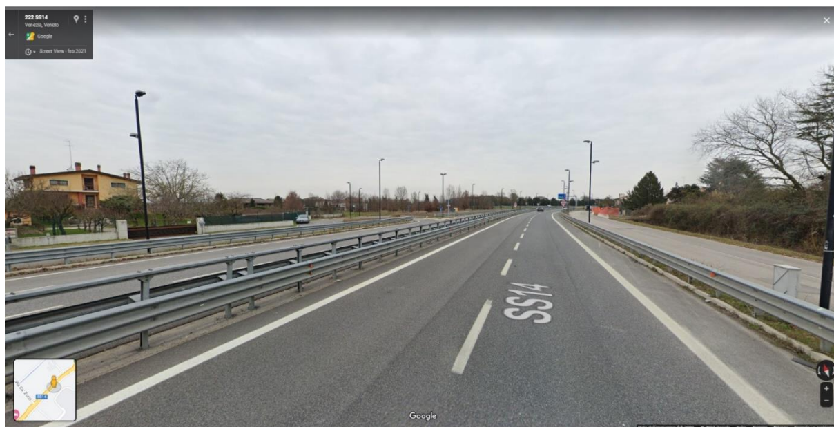
FIGURA 3: VISTA DELLA S.S. 14 NEL TRATTO DI FRONTE ALL'AEROPORTO MARCO POLO DI VENEZIA
