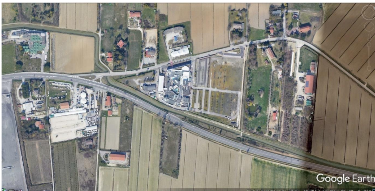
FIGURA 5: VISTA DELLA S.S. 14 AD EST DELL'AEROPORTO MARCO POLO IN ZONA CA' NOHERA
