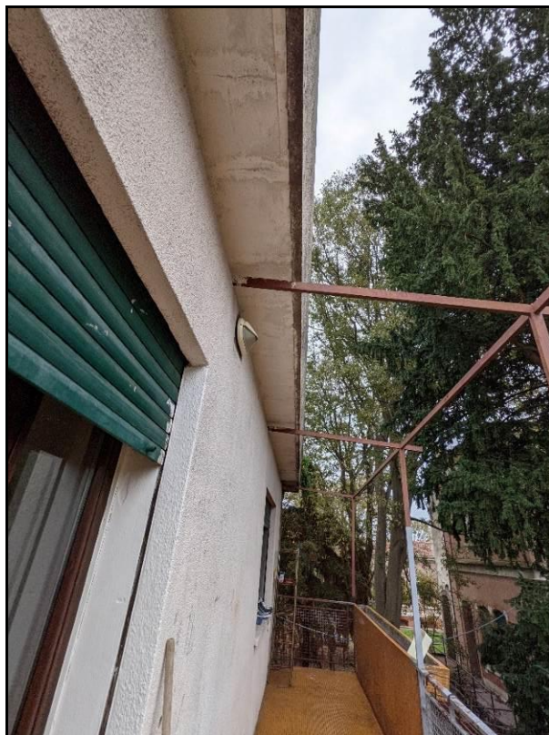
9. Dettaglio della cornice di gronda e del pergolato in struttura metallica che verrà conservato.
