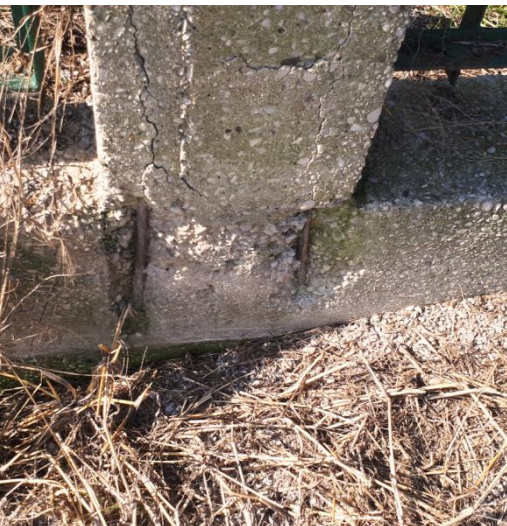
Foto 8: muretti di fondazione degrado superficiale
