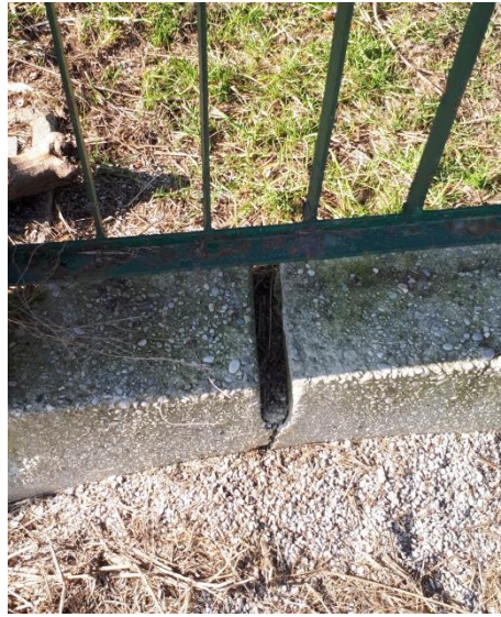
Foto 6 - 7: muretti di fondazione giunto di costruzione
