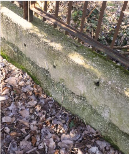
Foto 8: muretti di fondazione degrado superficiale
