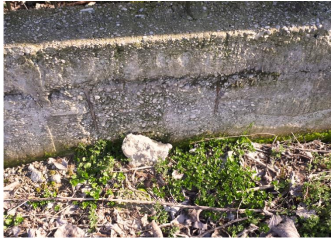
Foto 9: distacchi corticali e ferri in luce
