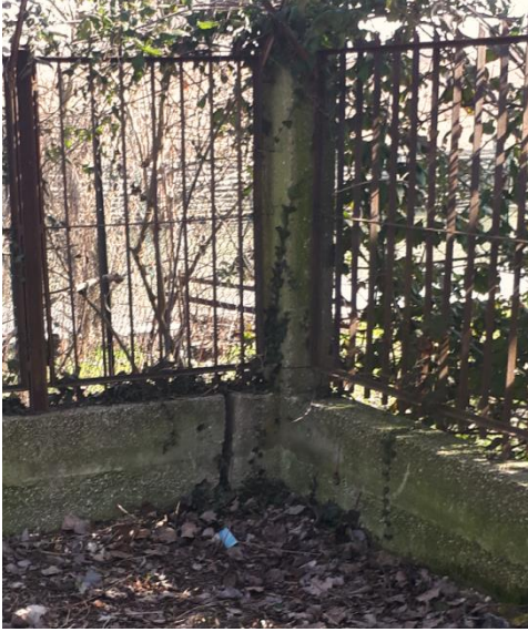
Foto 6 - 7: muretti di fondazione giunto di costruzione
