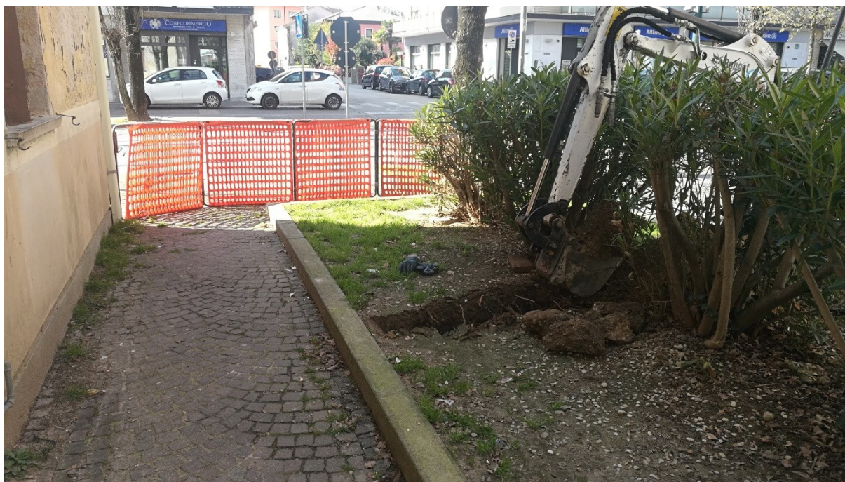
Fig. 12 - Esecuzione indagine di ricerca sottoservizi.
