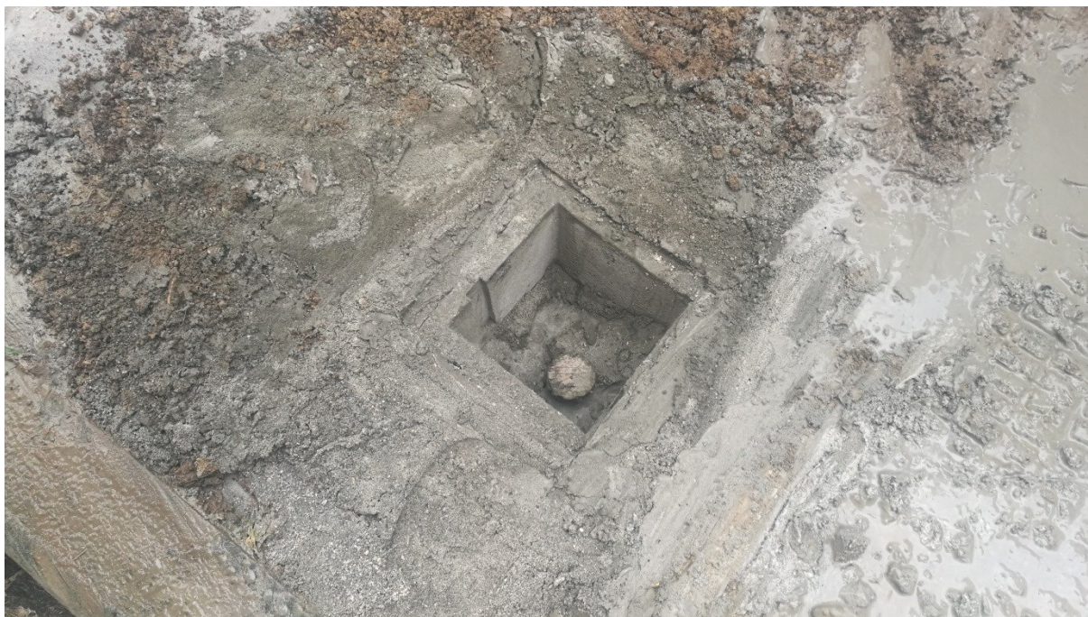
Fig. 11 - Dettaglio del piezometro realizzato.
