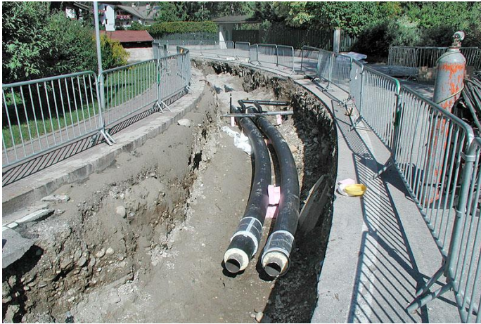
Fig. 05 – Parapetti protettivi a bordo scavo
