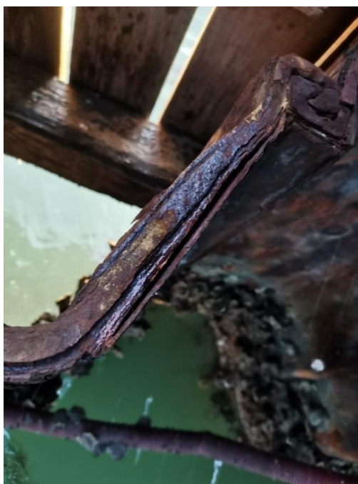
Fig. 2.2.5: Dettaglio degli effetti di corrosione del palancolato metallico
