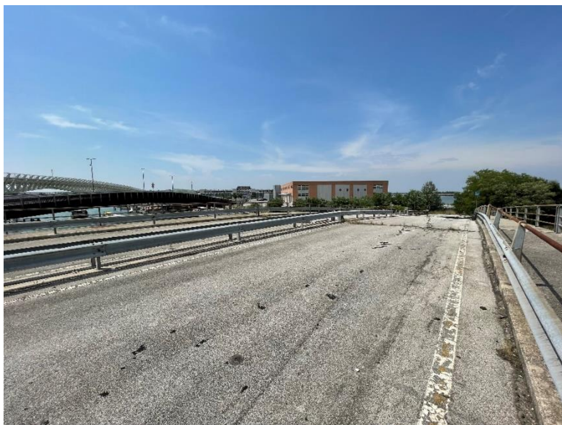
Foto dello stato di fatto – Tratto II, vecchio ponte del Tronchetto.
