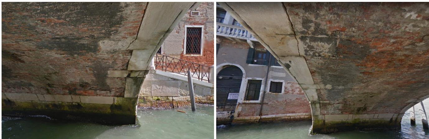
Figura 9.10: Lesioni delle chiavi e giunto tra armilla e volta in corrispondenza del fronte sud del ponte
