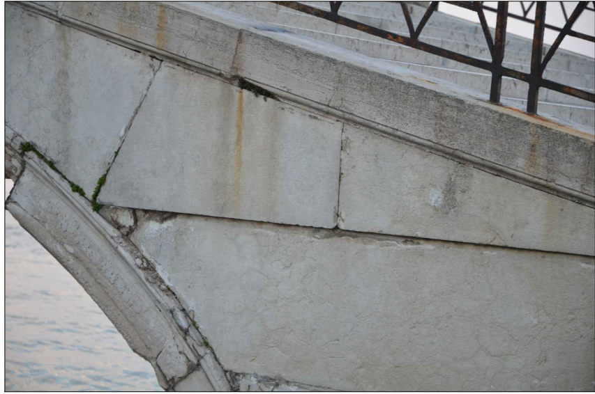
Lastre del rivestimento lapideo distaccate dal paramento murario del ponte
