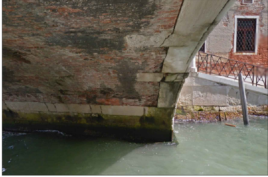
Vista delle lesioni della chiavi in pietra di connessione con la volta in muratura
