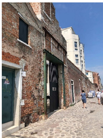
Fondamenta nove – dissenti localizzate delle murature
