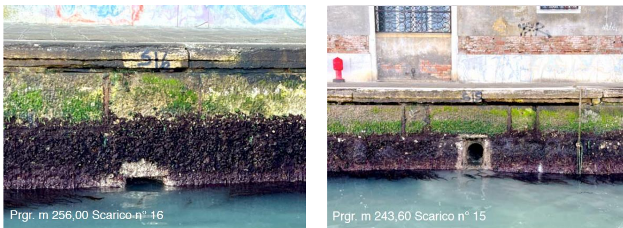
Figura 9.6 – 9.7: Stato di degrado delle listoline in pietra
