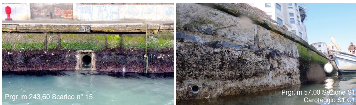
Figura 9.1 – 9.2: Vista della riva con evidente erosione dell'allettamento in malta sotto alle listoline
