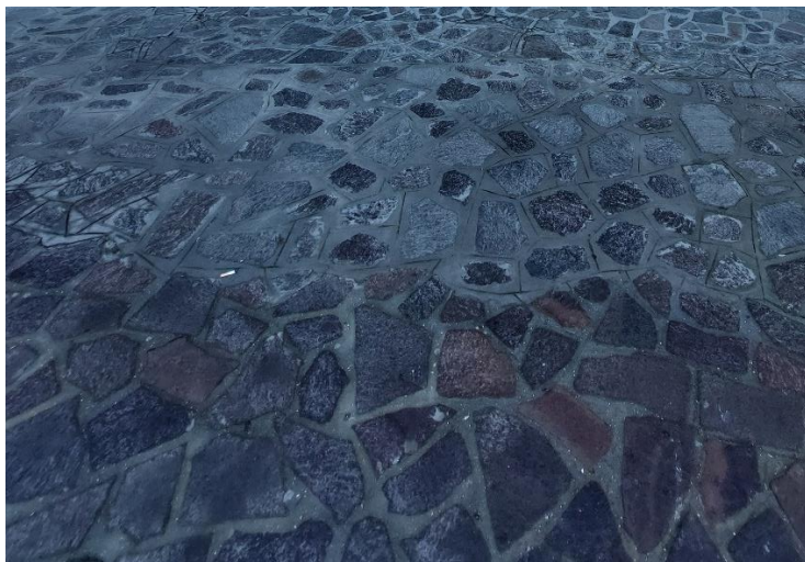
Figura 11.4-11.5 Pavimentazione in porfido a spacco presente attualmente sull'ultimo tratto delle Fondamente Nove, e tipologia prevista dall'intervento ripresa dal tratto precedente a Ponte Donà
