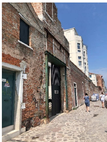
Fondamenta nove – dissenti localizzate delle murature
