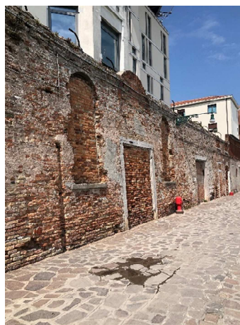
Fondamenta nove – dissenti localizzate delle murature
