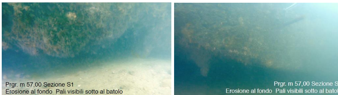
Figura 9.4 – 9.5: Immagini subacquee dell'erosione presente sotto al batolo al piede del muro di sponda
