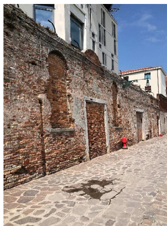
Fondamenta nove – dissenti localizzate delle murature
