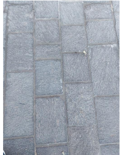
Figura 3.6-3.7 Pavimentazione in porfido a spacco presente attualmente sull'ultimo tratto delle Fondamente Nove, e che prevede il progetto ripresa dal tratto precedente a Ponte Donà
