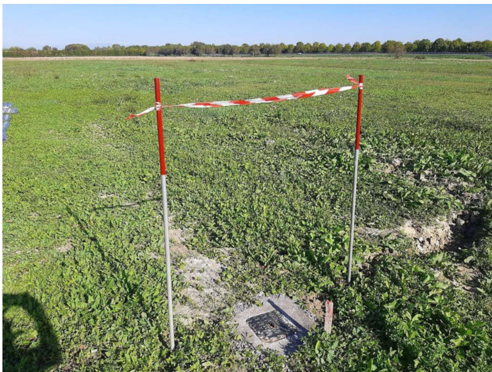
Foto sistemazione finale chiusino carrabile piezometro a tubo aperto
