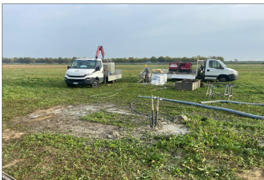
Cementazione sonda geotermica
