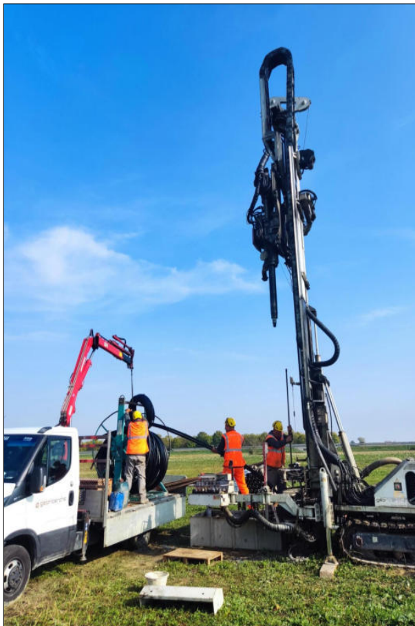
Installazione sonda geotermica
