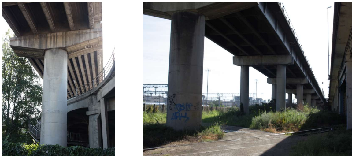
Figura 3 – A sinistra impalcato e pila a fusto unico, a destra impalcato e pila a doppio fusto
