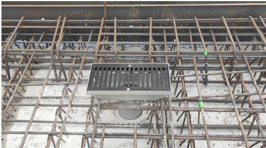
Figura 17 – esempio di caditoia da impalcato DN400
