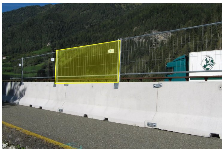
Simulazione di varco da realizzare ogni 50 metri.
