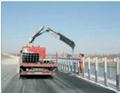
Situazione non regolare, i lavoratori sono privi di casco e il gancio dell'autogru è privo di sistema antiscandalo
