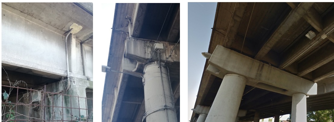
foto rappresentative degli impianti installati all'estradosso dell'impalcato e sulle pile, prevalentemente impianti di I.P.
