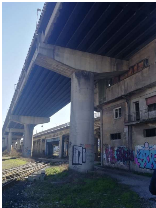
Figura 10 Pila a fusto singolo
