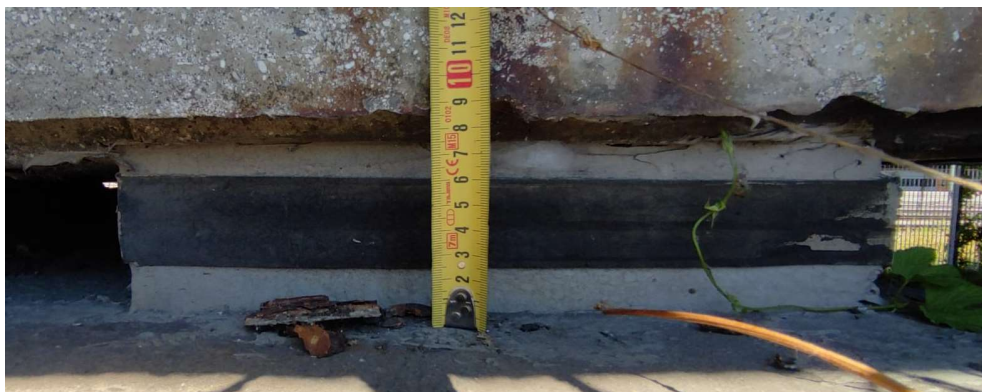
Figura 33 Appoggi in neoprene - Rampa A
