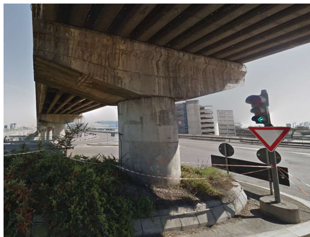
Figura 11 Pila a fusto singolo - Corso del popolo
