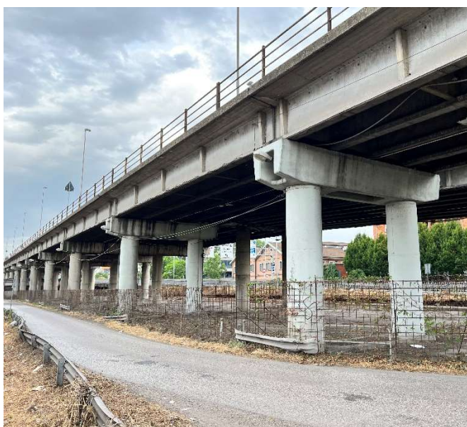
Figura 9 Pile a fusto doppio
