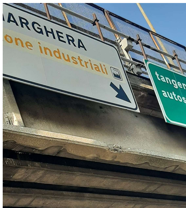
Figura 5 Particolare danno d'urto sulla trave di bordo
