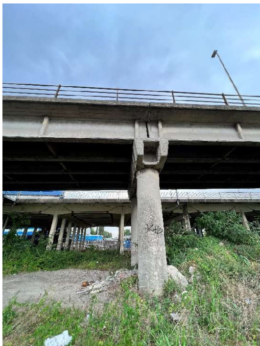
Figura 6 Pila a telaio a fusto doppio
