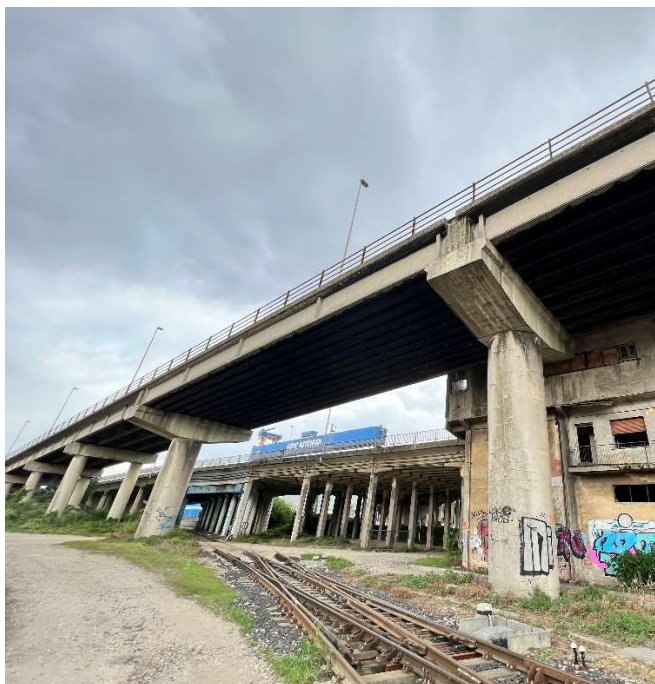
Figura 7 Pila a fusto singolo
