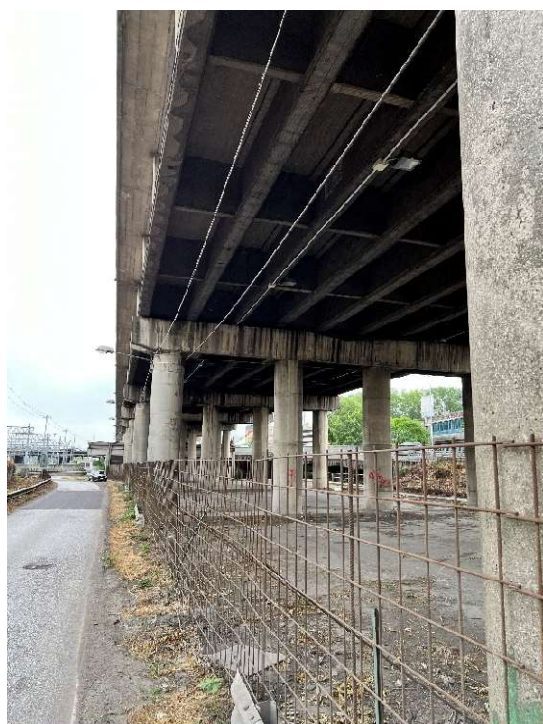
Figura 8 Pila a 4 fusti
