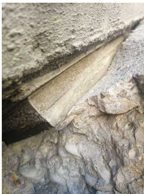
Figura 12 – Appoggio in elastomero armato
