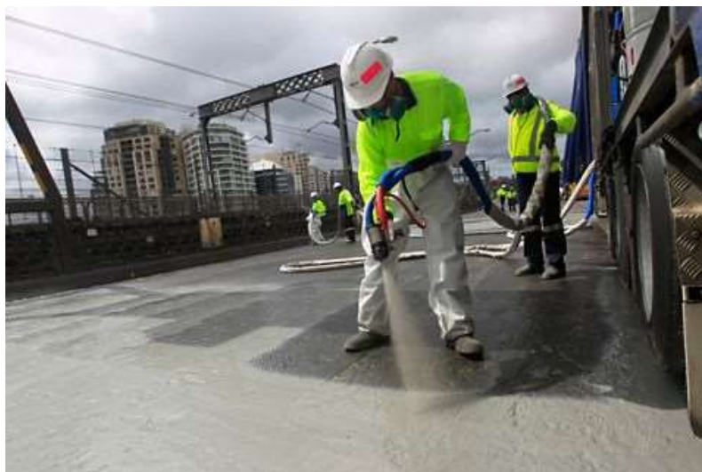
Figura 12 – esempio della posa a spruzzo della malta epossicementizia
