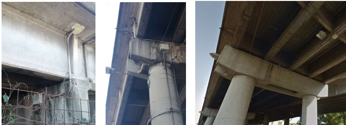
Figura 19 – foto rappresentative degli impianti installati all'estradosso dell'impalcato e sulle pile, prevalentemente impianti di I.P.
