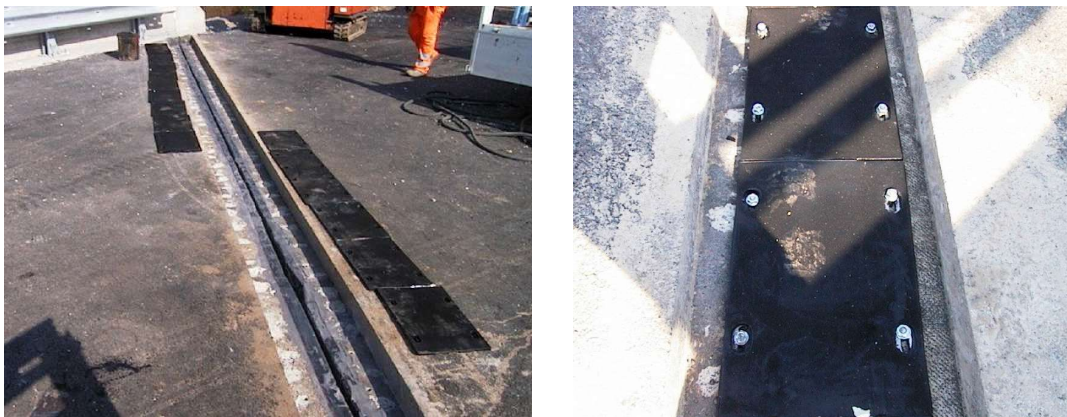
Figura 15 – esempio di applicazione di giunto sottopavimentazione in acciaio-elastomero
