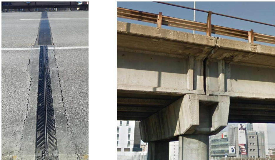
Figura 13 – giunto singolo – su pile a due o più fusti
