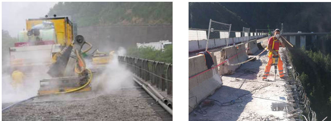
Figura 10 – a sinistra idrodemolizione confinata, a destra demolizione del cordolo laterale di un impalcato
