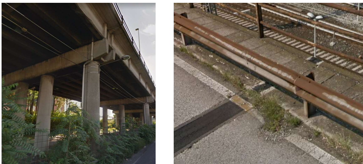
Figura 16 – a sinistra tubazioni presenti sulle pile per lo scarico a terra, a sinistra caditoia ostruita
