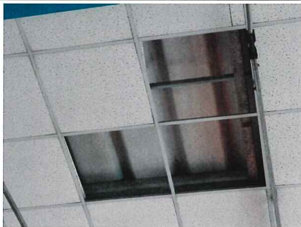
SOFFITTATURA EDIFICIO 1 CON LASTRA DI SOTTOCOPERTURA IN AMIANTO
