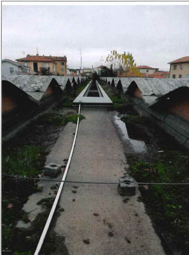
Canale di gronda tra coperture zona Parcour e Protezione Civile con vuoto
