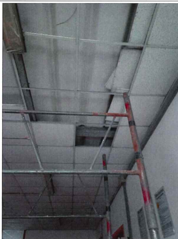
ISPEZIONE AL SOFFITTO PER CONTROLLO ORDITURA, LASTRE IN CEMENTO AMIANTO ED APPICCAGLIATURE
