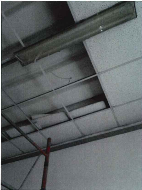
APPICCAGLIATURA DEL SOFFITTO ALLA LASTRA IN CEMENTO AMIANTO
