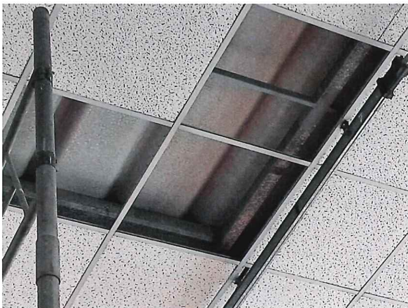
SOFFITTO E LASTRA DI SOTTOCOPERTURA IN CEMENTO AMIANTO LABORATORIO EDIFICIO 1
