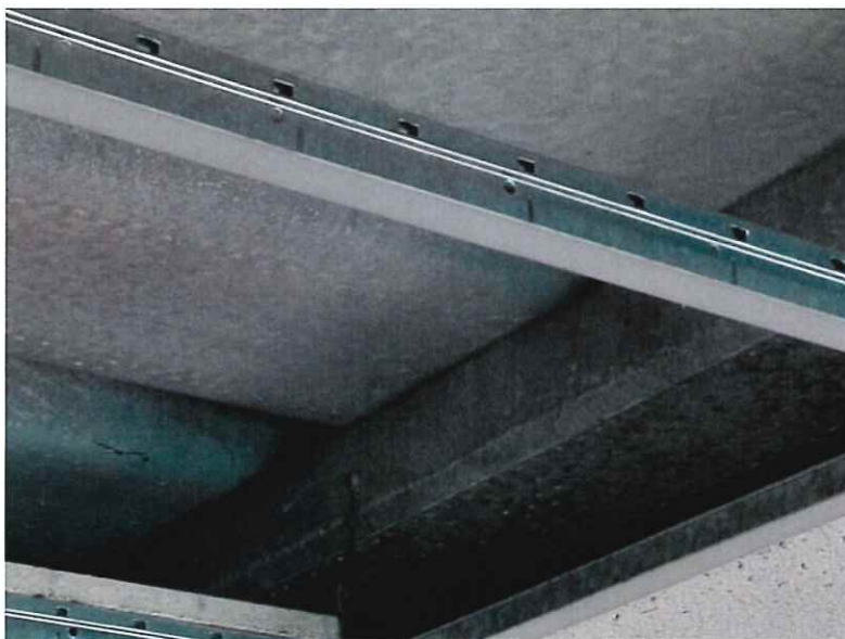
SOFFITTO E LASTRA DI SOTTOCOPERTURA IN CEMENTO AMIANTO LABORATORIO EDIFICIO 1
