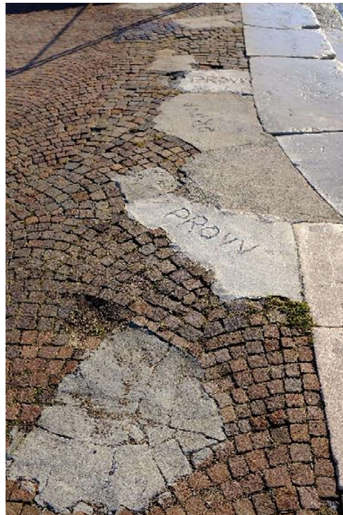
pavimentazione in blocchetti di porfido a coda di pavone
