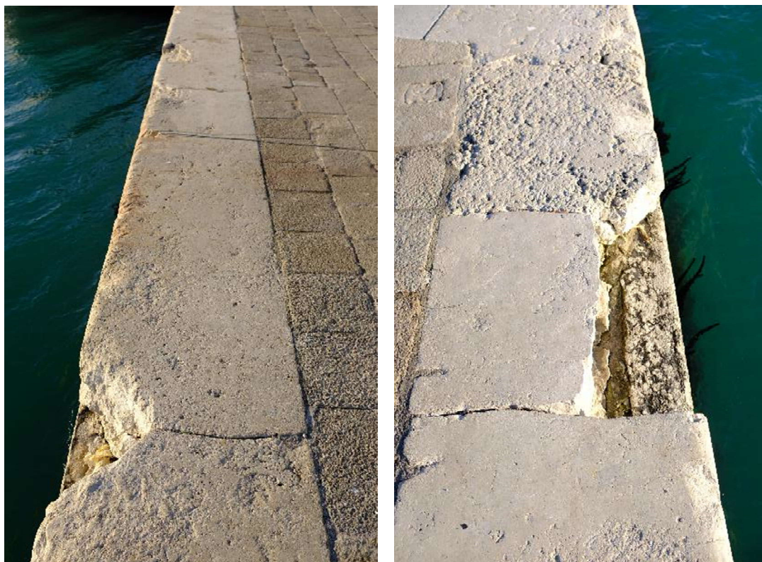
dissesti dei bolognini della tipologia 1 e 2 sopra descritte
