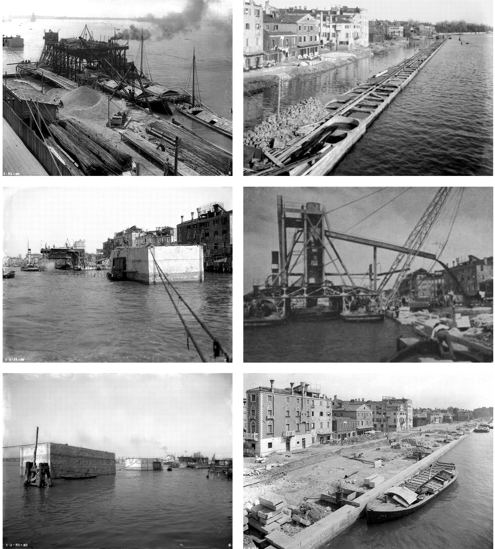
Foto realizzate durante la costruzione di Riva dell'Impero, in cui si vedono i cassoni galleggianti che vengono trasportati verso il luogo di affondamento e il successivo riempimento della fascia fra i cassoni stessi e le precedenti rive con ghiaia e sabbia mista ad inerti da demolizione, infine la costruzione del muro di sponda. (Foto Archivio Giacomelli)
