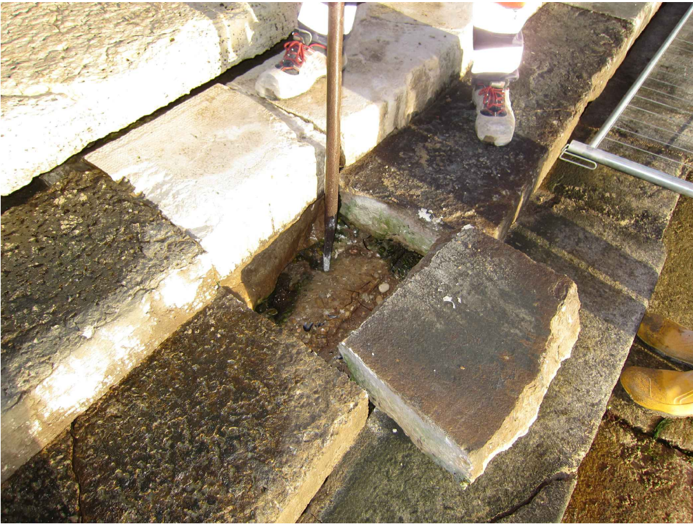
Spostamento di un blocco di marmo scollegato della riva centrale
