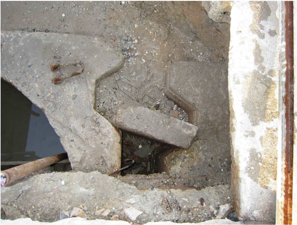
Sondaggio S.09: rilievo della geometria del giunto tra i cassoni e dell'elemento posto tra essi per bloccare la fuoriuscita del materiale di riempimento delle sponde
