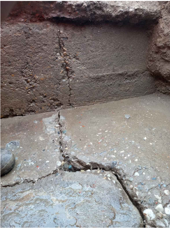
Sondaggio S.03: fessurazione del muro di sponda in corrispondenza del giunto tra i cassoni
