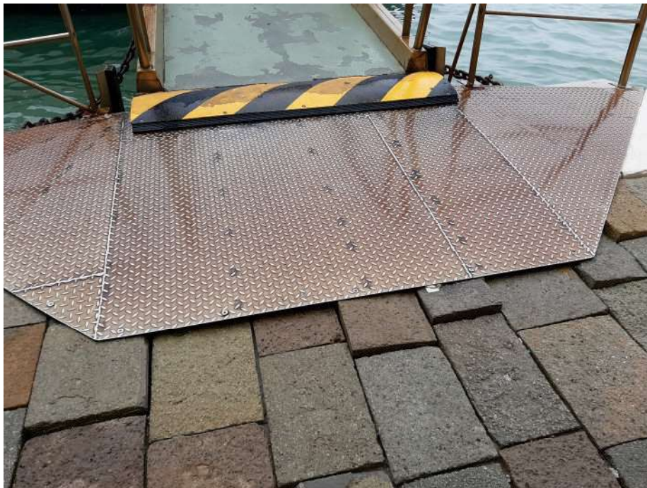
Stato dei luoghi – Fondamenta delle Zattere (particolare dell'abbassamento pavimentazione per sifonamenti)
