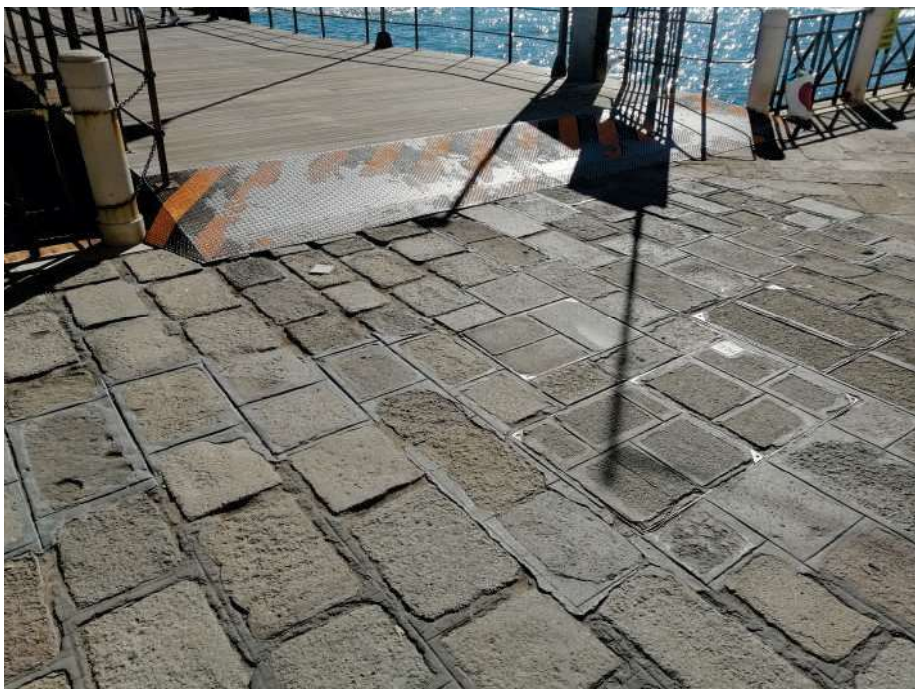
Stato dei luoghi – Fondamenta delle Zattere (particolare dell'abbassamento pavimentazione per sifonamenti)
