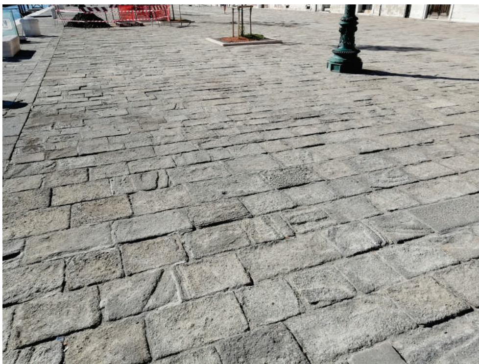
Stato dei luoghi – Fondamenta delle Zattere (zone soggette a fenomeni di erosione della pavimentazione)
