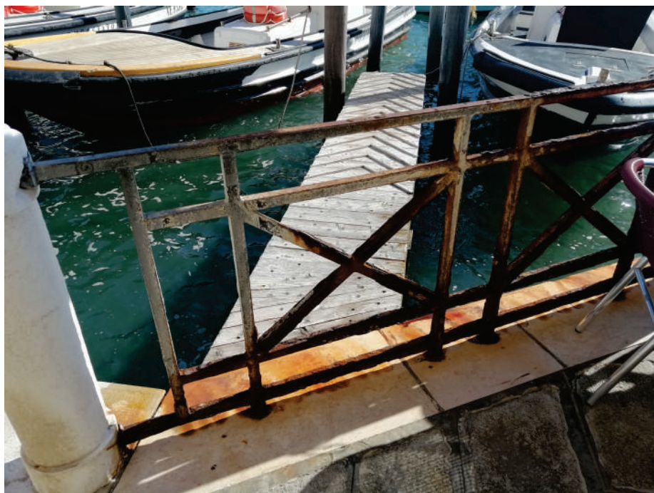
Stato dei luoghi – particolare parapetti metallici
