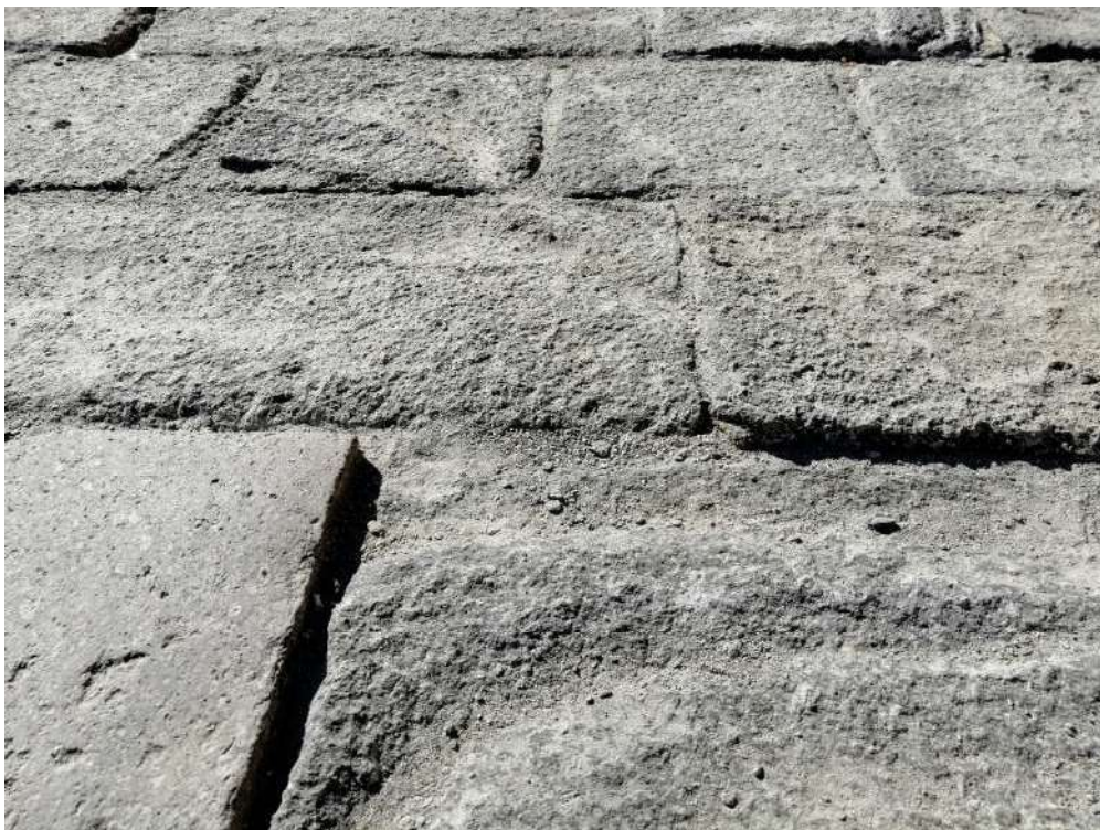
Stato dei luoghi – Fondamenta delle Zattere (particolare dello stato d'erosione della pavimentazione)
