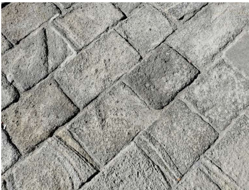
Stato dei luoghi – Fondamenta delle Zattere (particolare dello stato d'erosione della pavimentazione)
