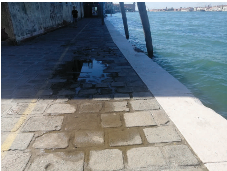
Stato dei luoghi – Riva Canale della Giudecca (particolare dell'abbassamento pavimentazione per sifonamenti)
