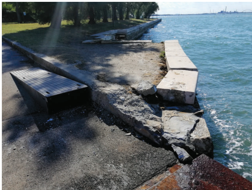
Stato dei luoghi – particolare coronamento lapideo danneggiato e/o fuorisede
