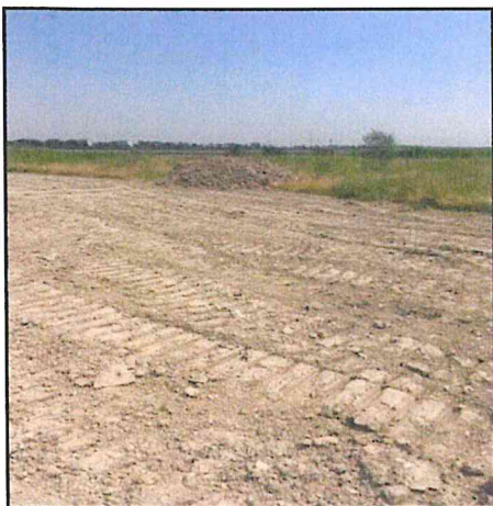
Stesa materiali a nord est (3)
