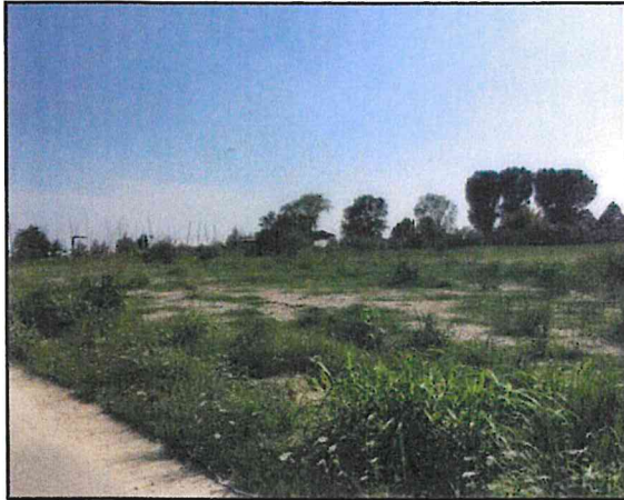
Stesa materiali lato a est - 8 agosto
