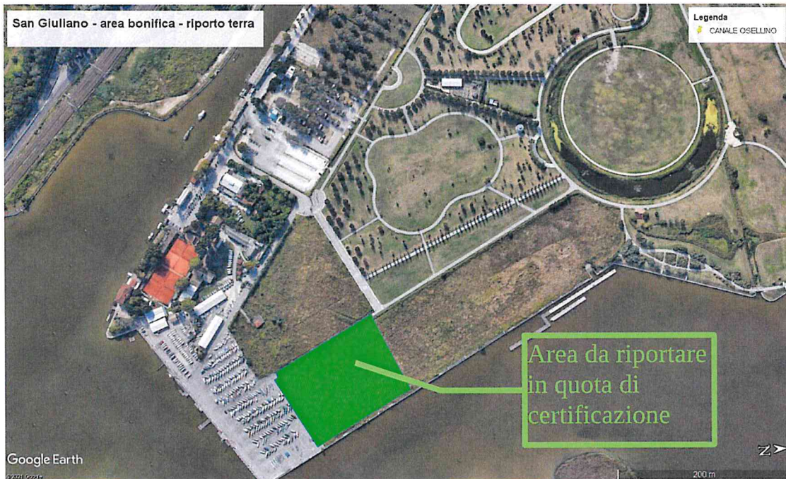
Fig.4- Parco San Giuliano -area recentemente bonificata e certificata da riportare in quota
