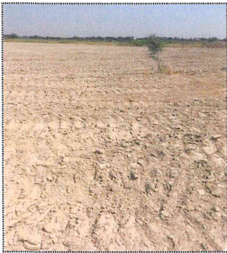
stesa materiali a nord est (1)
