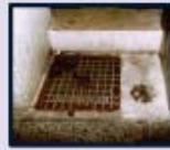
CHIUSINO IN GHISA VALVOLA DI SCARICO
