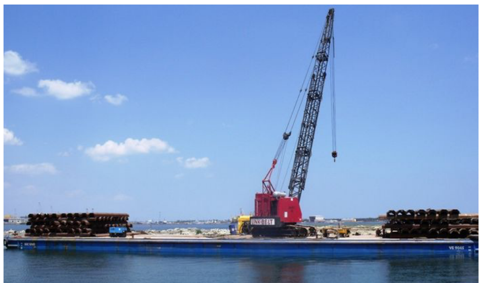
Esempio di lavorazione con gru su pontone galleggiante
